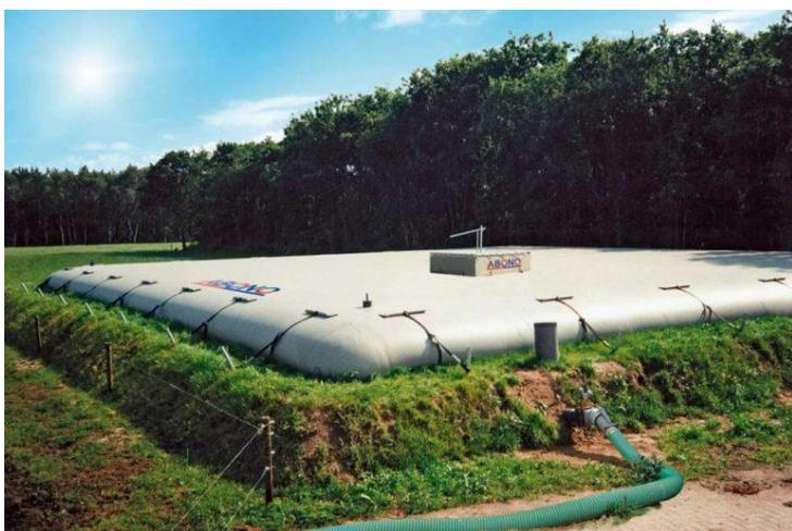
**Рисунок 76 – Лагуна закрытого типа**
